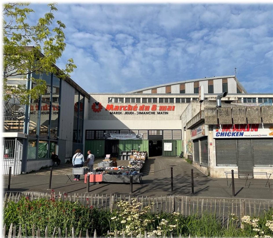
Accès est rue Ampère
