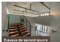
Travaux de second œuvre
