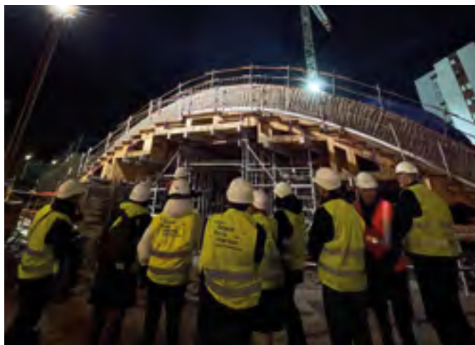
► La voûte de la grotte, futur accès à la gare Mairie-de-Vitry-sur-Seine du Grand Paris Express.
