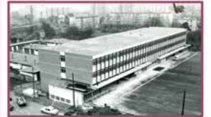
Notre école en construction
