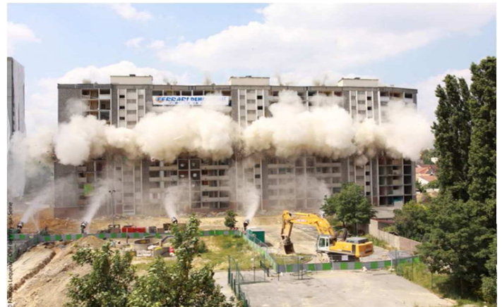
Démolition de la tour GHJ le 5 septembre 2012
