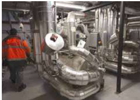
Travaux patinoire municipale
