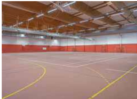
La rénovation de l'éclairage de la Halle des sports Rabelais
