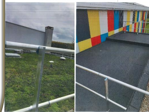
Isolation des toitures terrasses de gymnases
