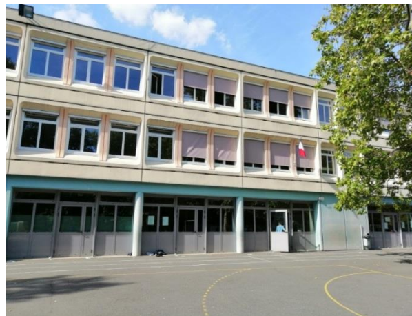
Remplacement des menuiseries de l'école élémentaire J. Moulin
