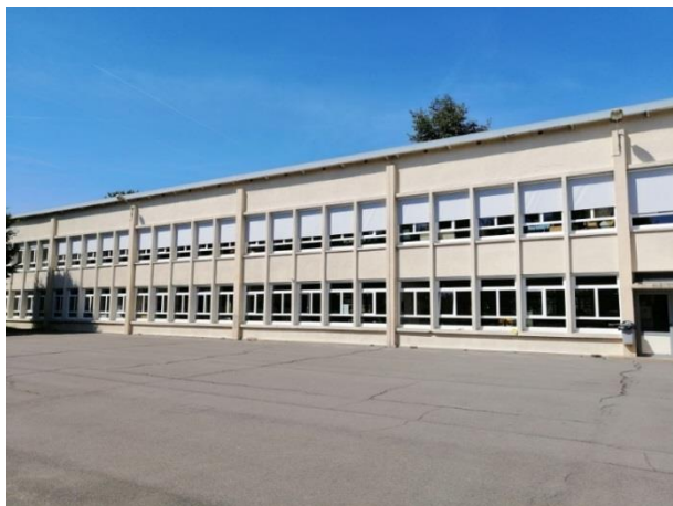
Remplacement des menuiseries de l'élémentaire Cachin
