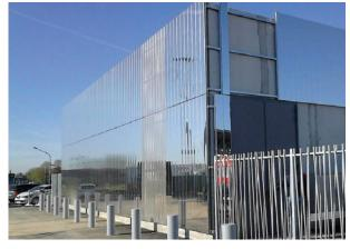
La station d'échange construite dans le MIN de Rungis permet de gérer la fourniture de chaleur entre les deux réseaux. Seules les calories sont échangées car les fluides caloporteurs (l'eau surchauffée) restent séparés. Le bâtiment conçu par la SEMMARIS reflète par un bardage inox l'environnement d'activité et de logistique du MIN.
