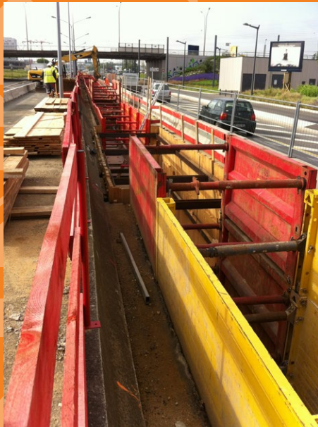
Photo de gauche : Travaux de réalisation de l'interconnexion sur la RD7. Photo de droite : Station d'échange entre les réseaux du SICUCV et du MIN.
