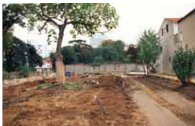
Parc du Coteau, aménagement du verger, passage des fourreaux pour le réseau d'arrosage, DR, 1997, (Bureau d'études des espaces verts)
