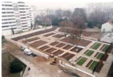
Jardins à thèmes, articulation des tranches réalisées et de la partie chantier, DR, 1998, (Bureau d'études des espaces verts)
