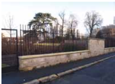
Réhabilitation du mur d'enceinte, rue Edouard Tremblay, Durand-Bestry, 2003, (Bureau d'études des espaces verts)
