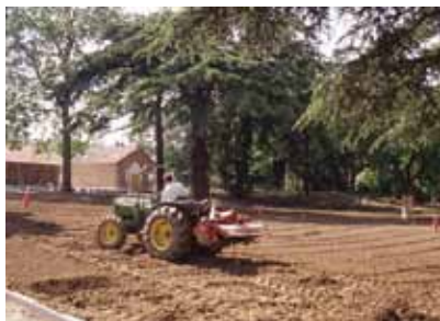
Espace central, travaux de terrassements, mai 1994, Michel Aumercier, (A.M. Vitry-sur-Seine, 4Fi)
