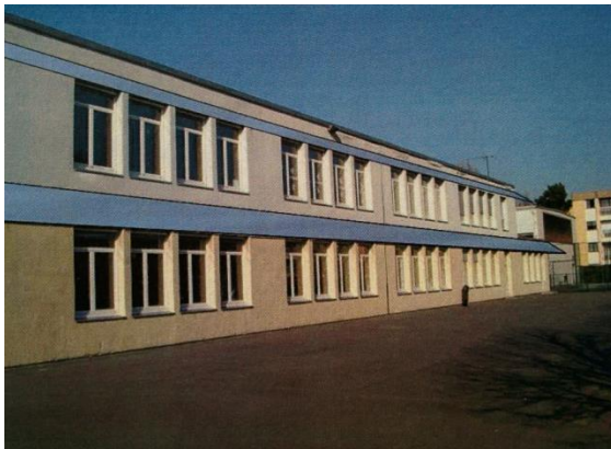
Panneaux photovoltaïque en brise soleil à l'école Paul Langevin
