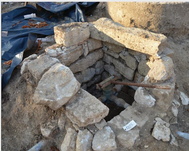
*Vue du regard maçonné abritant le robinet ancien. Les dalles de couverture ont été ôtées. En position centrale, le robinet en bronze est soudé à trois tuyaux de plomb. Sa tige de manoeuvre en fer repose sur la maçonnerie du regard.*
