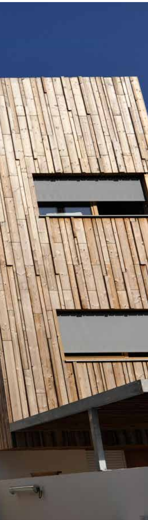
Résidence Jules Lagaisse, rue Lagaisse.
